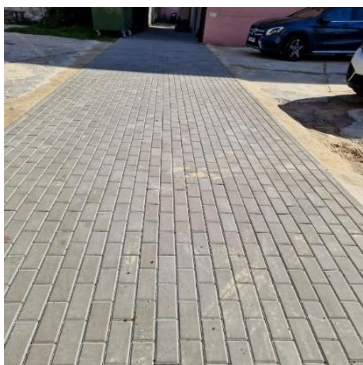
Zdjęcie nr 2: Część placu parkingowego po remoncie
