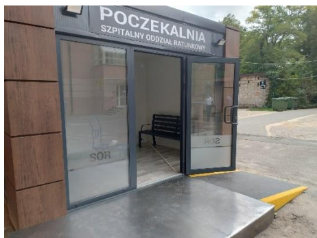
Zdjęcie nr 3: Montaż mobilnego pawilonu poczekalni dla pacjentów ze szczególnymi potrzebami
